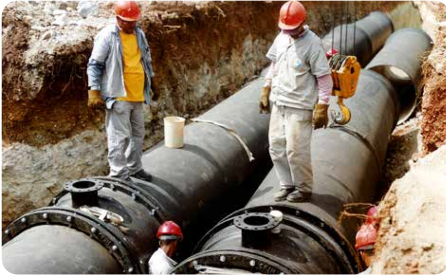
Assentamento de canalizações para o fornecimento de água potável
