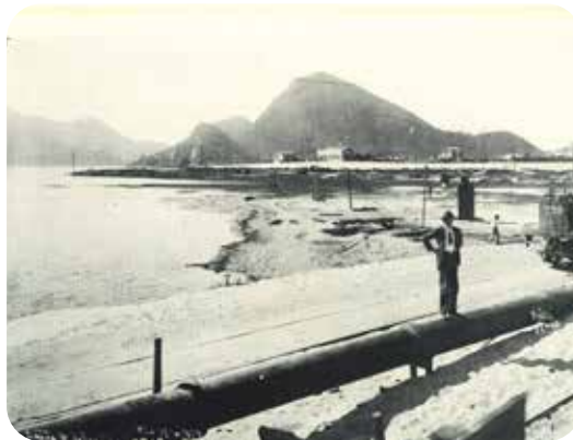
Obra de saneamento na Lagoa Rodrigo de Freitas, Rio de Janeiro, no século XIX. Instalações em ferro fundido que perduram até hoje
