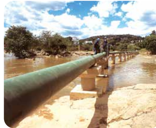
Adoção da técnica de assentamento aéreo de tubos em vãos duplos, que não seria possível com outro material
