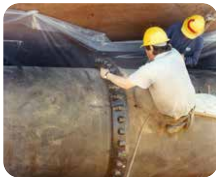
Opção de travamento externo, possibilitando a eliminação de blocos de ancoragem
