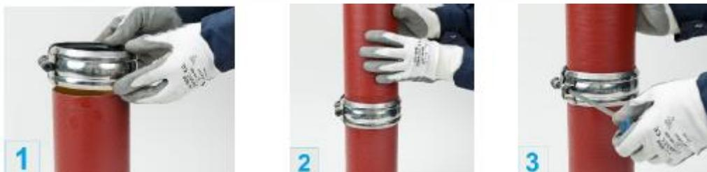
1. Posicionar a vedação na primeira extremidade plana, de modo que ela apoie na aba central do anel de borracha;
